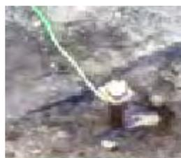
Le fil a eu l'habitude de communiquer avec la barre de terre il est est très important et ne devrait pas être moins de 8 swg fil de cuivre, c'est-à-dire diamètre de 4 millimètres et 13 millimètre sq.. région trans-à
