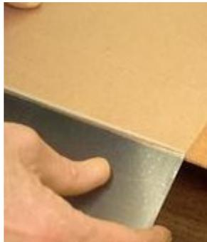
Maintenant, pour créer les trous sur celui-ci, nous allons utiliser les trous qui se trouvent sur le support, et les aligner sur le plexiglas. Pour cela, dévissez le support du cadre principal, et placez-le sur le plexiglas :
